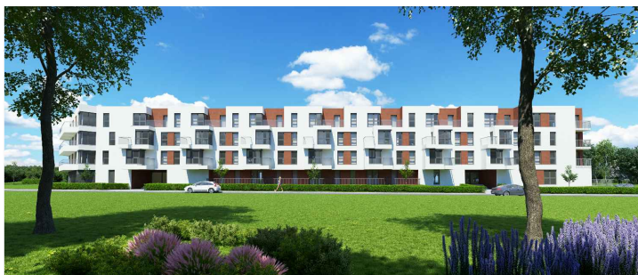
BUDYNEK WIELORODZINNY PRZY ULICY ZIELNEJ WE WROCŁAWIU
