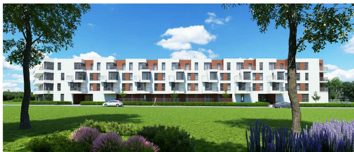
BUDYNEK WIELORODZINNY PRZY ULICY ZIELNEJ WE WROCŁAWIU
