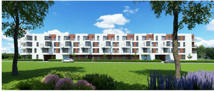
BUDYNEK WIELORODZINNY PRZY ULICY ZIELNEJ WE WROCŁAWIU
